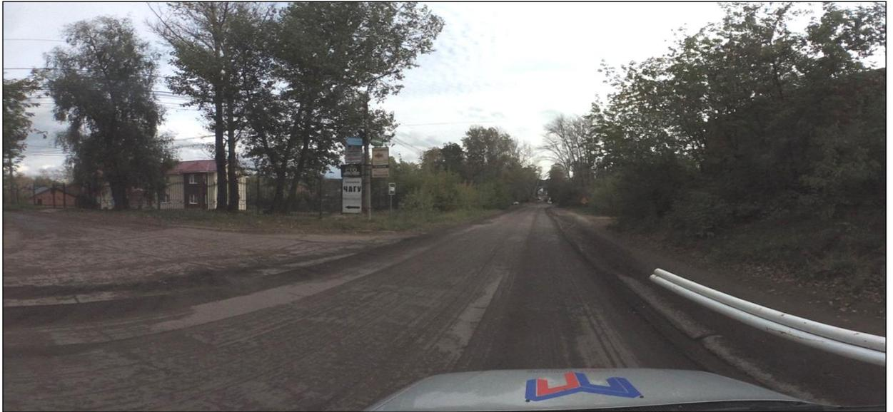
Рисунок 1.4.14 – Состояние дорожного покрытия ул. Луговая (от ул. Промышленной до ул. Юбилейной) на момент обследования
