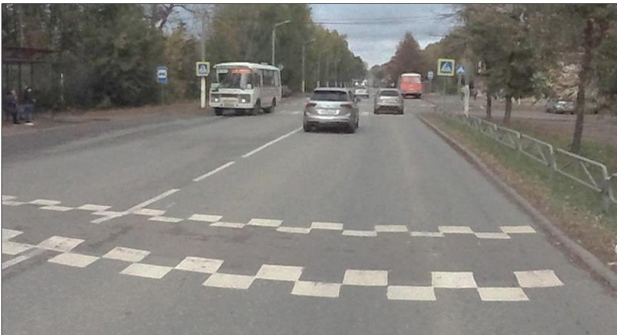
Рисунок 1.7.5 – Пример эксплуатационного состояния искусственной неровности монолитной конструкции, расположенной по ул. Вокзальная
