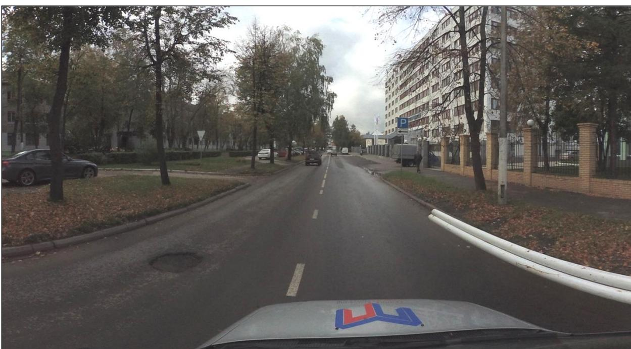
Рисунок 1.4.4 – Состояние дорожного покрытия бул. Приморский (от ул. Мира до ул. Ленина) на момент обследования
