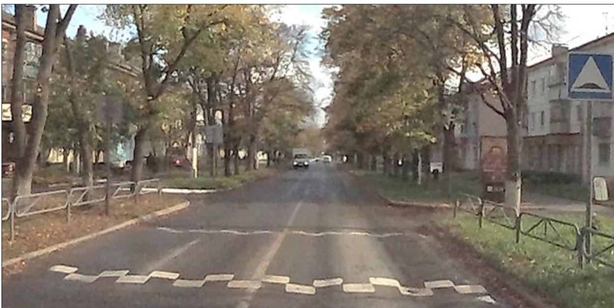
Рисунок 1.7.6 – Пример ненадлежащего эксплуатационного состояния (наличие просадок, нарушение геометрии) ИН монолитной конструкции, расположенной по ул. Карла Маркса
